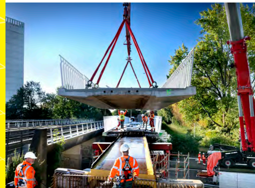
Das Einheben der Fahrradbrücke über die Umgehungsstraße. Sie ist Teil des Radschnellwegs Winsum-Groningen. FOTO: PETER WASSING
