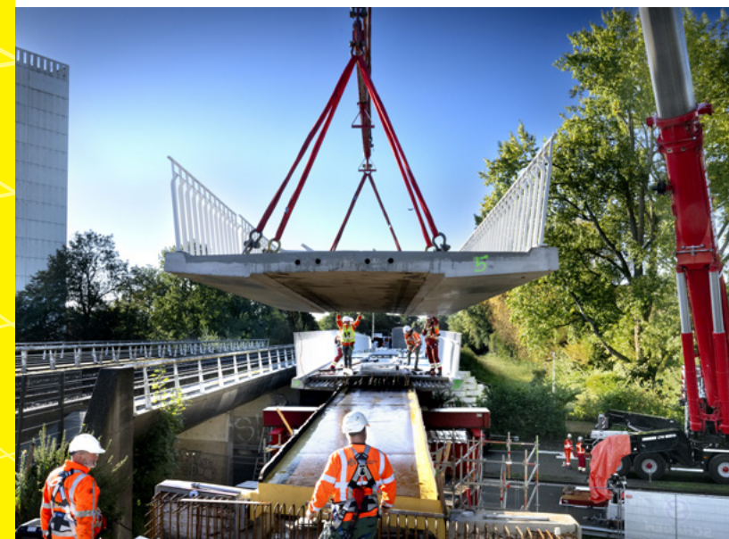
Het intakelen van de fietsbrug over de ringweg, onderdeel doorfietsroute Winsum - Groningen. FOTO: PETER WASSING
